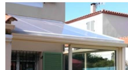
**Toiture en panneaux polycarbonate**
